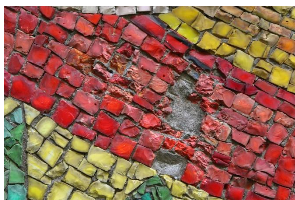
Obr. 14: Detail mozaiky Cirkus – degradované a scházející mozaikové kostky. Stav před restaurováním.
