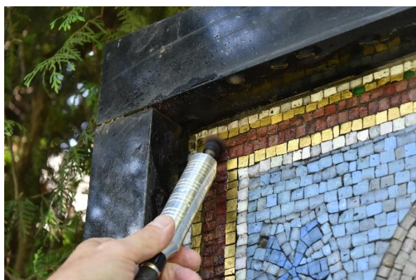
Obr. 33: Mozaika na náhrobku Jana Tumpacha na Vinohradském hřbitově. Průběh odstraňování tmavého povlaku pomocí mikrobrusky a kotoučů z jemného brusného rouna.
