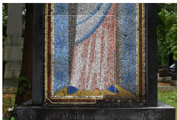
Obr. 36: Mozaika na náhrobku Jana Tumpacha na Vinohradském hřbitově. Rozšířená zkouška čištění pomocí mikrobrusky a kotoučů z jemného brusného rouna.
