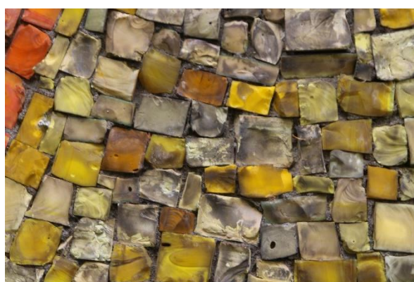
Obr. 16: Detail mozaiky Cirkus – znečištění tmavým povrchovým povlakem. Stav před restaurováním.
