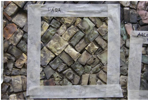
Obr. 24: Zkoušky čištění mozaiky v Praze-Vršovicích. Zkouška čištění pomocí parního čističe za současného mechanického namáhání čisticími kartáčky.
